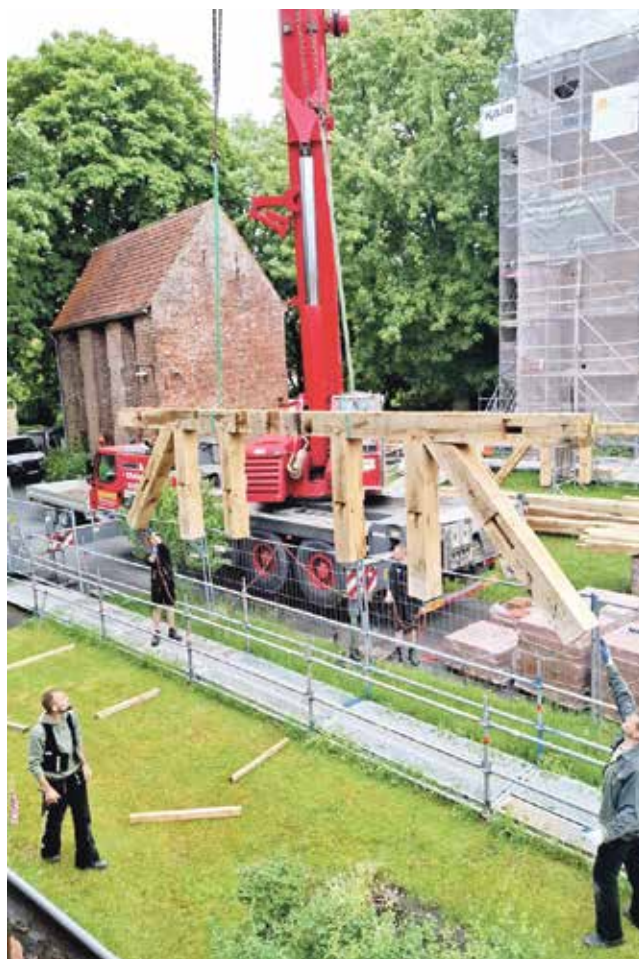
Die ersten Teile des Turmdachstuhls werden eingebaut. (Foto: Will)
